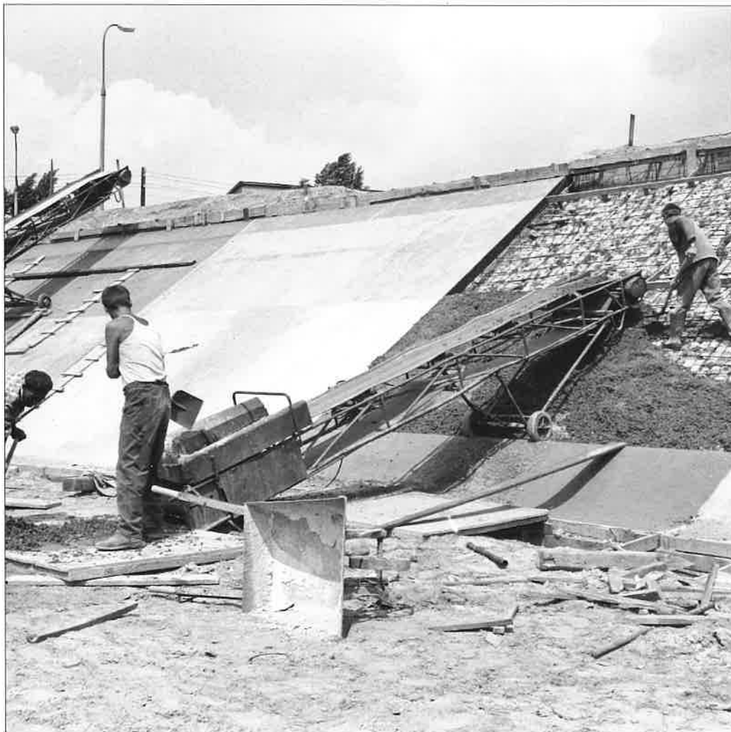
Budowa toru kolarskiego w latach 1970-1972, widoczny bruk z kostki bazaltowej i granitowej oraz poniżej widoczna podbudowa dla betonowej powierzchni toru. (źródło: Narodowe Archiwum Cyfrowe, audiovis.nac.gov.pl ; sygn. 40-W-102-7)
