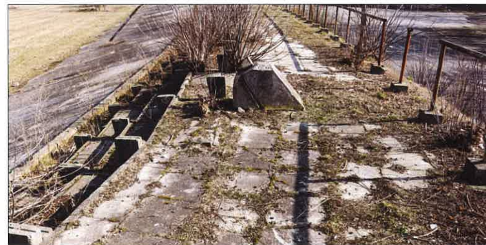
Południowo-zachodni szczyt nasypu toru kolarskiego, widoczne zniszczone ławki na trybunach i betonowa podstawa lampy oświetleniowej. (fot. Jakub Andrzejewski, 2020 r.)
