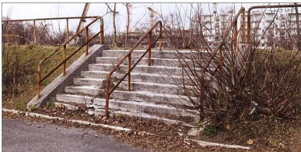
Schody prowadzące na południowy szczyt nasypu toru kolarskiego. (fot. Jakub Andrzejewski, 2020 r.)
