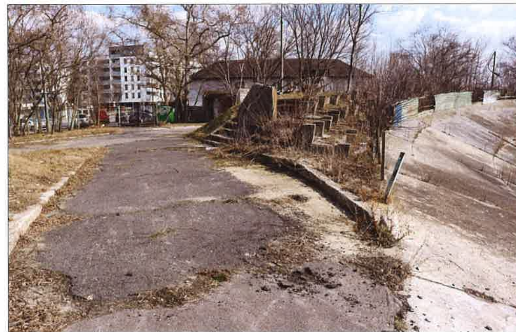
Wjazd na tor kolarski od strony ul. Mińskiej, widok w kierunku północno-wschodnim. (fot. Jakub Andrzejewski, 2020 r.)
