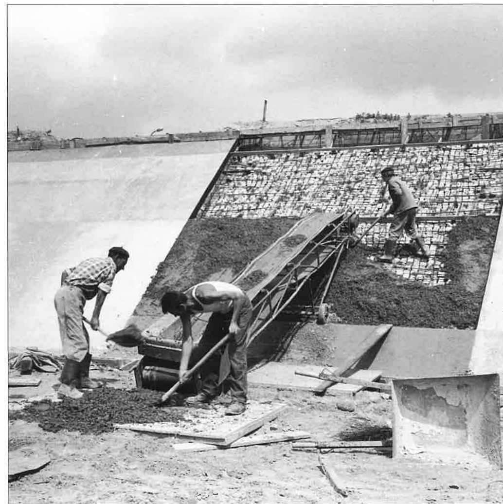
Budowa welodromu w latach 1970-1972, betonowanie powierzchni jezdni toru, zbrojonej prętami stalowymi, poniżej widoczna podbudowa z kostki bazaltowej i granitowej. (źródło: Narodowe Archiwum Cyfrowe, audiovis.nac.gov.pl; sygn. 40-W-102-6 )
