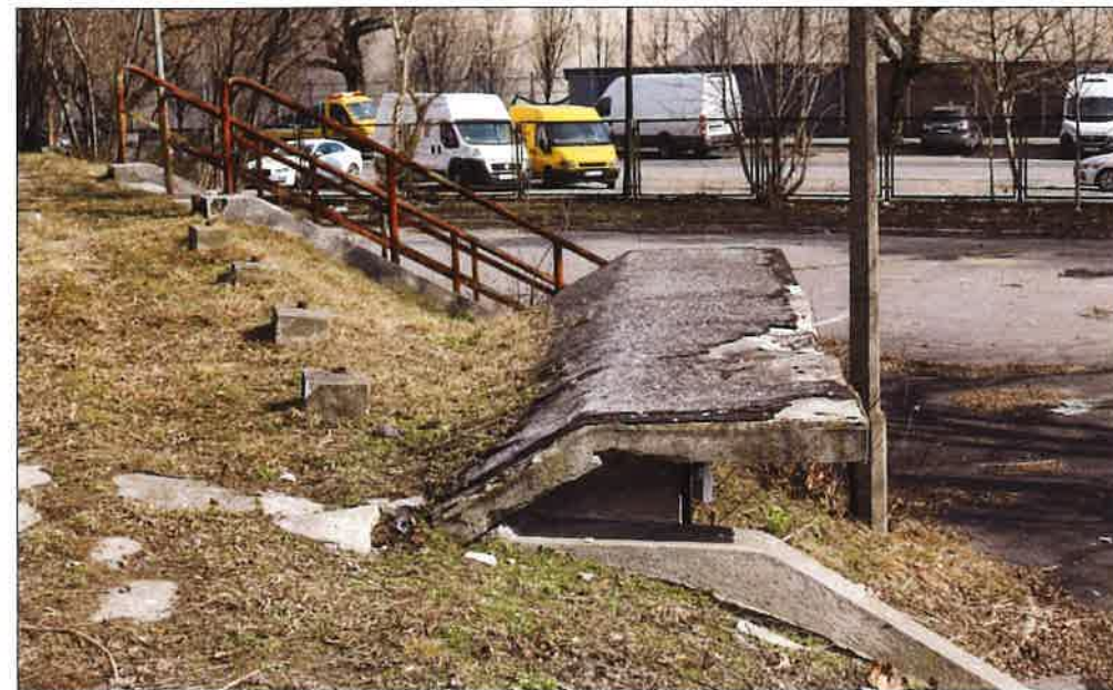
Widoczny fragment żelbetowego zadaszenia przejścia podziemnego po zewnętrznej stronie toru, z widoczną wierzchnią warstwą papy. (fot. Jakub Andrzejewski, 2020 r.)
