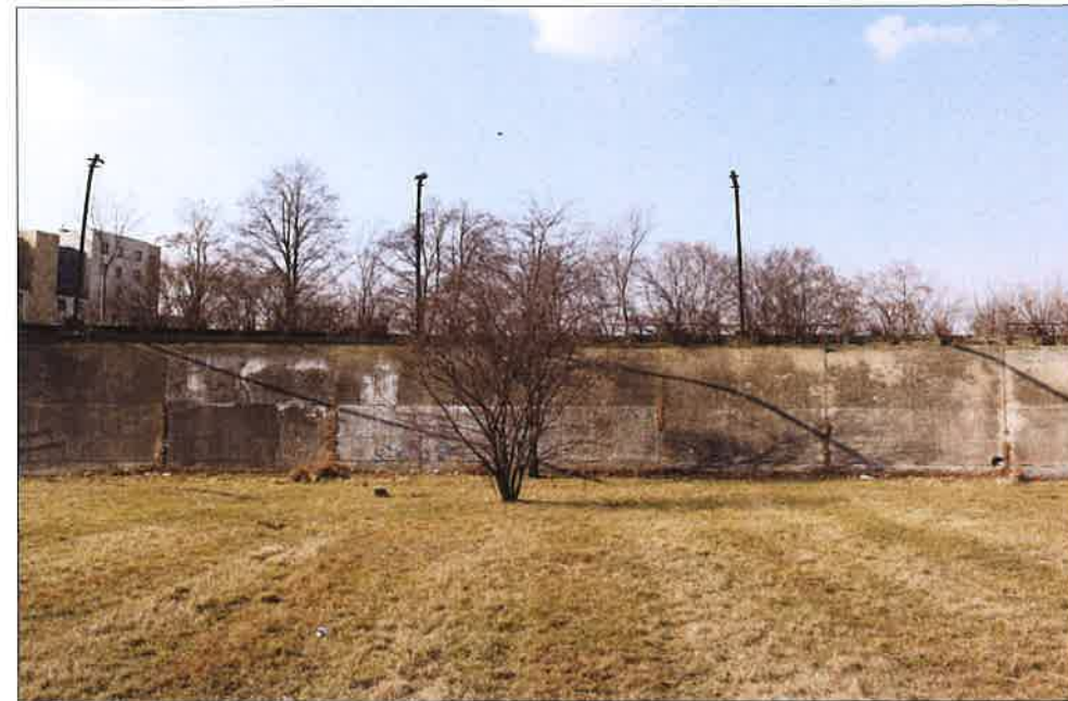
Widok południowo-zachodniej części toru kolarskiego - wezglowia, w najwyższej części betonowego toru jezdnej. (fot. Jakub Andrzejewski, 2020 r.)
