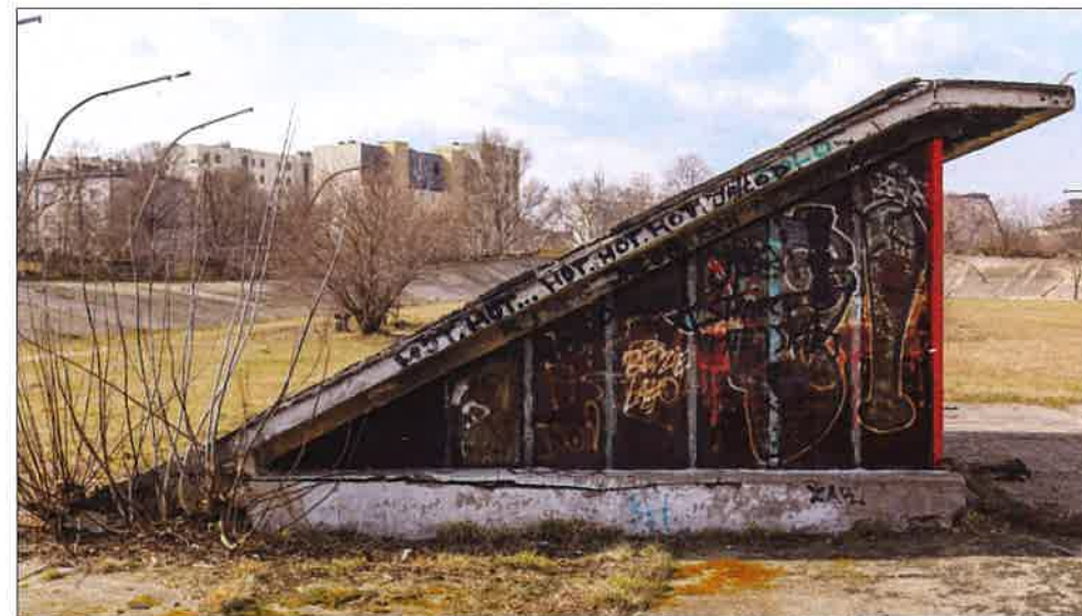
Żelbetowe zadaszenie przejścia podziemnego po wewnętrznej stronie toru, widok od strony północno-wschodniej. (fot. Jakub Andrzejewski, 2020 r.)
