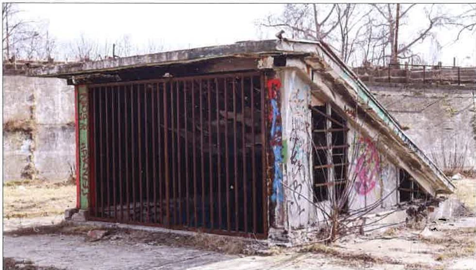
Żelbetowe zadaszenie przejścia podziemnego po wewnętrznej stronie toru, widok od strony zachodniej. (fot. Jakub Andrzejewski, 2020 r.)
