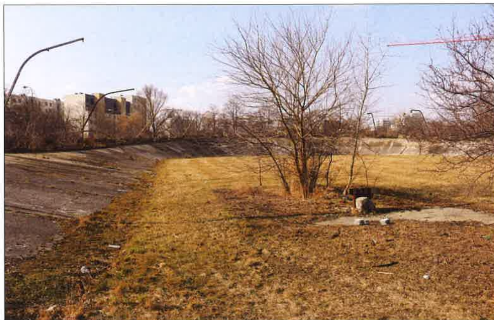
Południowa część welodromu z widocznym po prawej stronie fundamentem słupów dawnego pomieszczenia (łóży) sędziów i komentatorów. (fot. Jakub Andrzejewski, 2020 r.)
