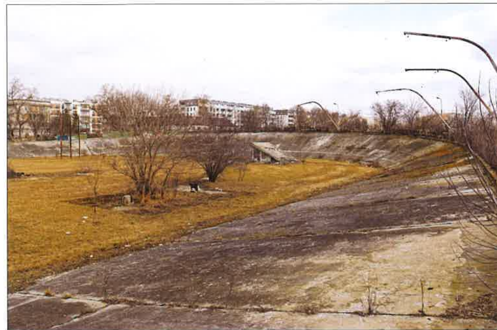
Północno-wschodnia części toru kolarskiego, z widokiem wyprofilowanej części jezdnej. (fot. Jakub Andrzejewski , 2020 r.)
