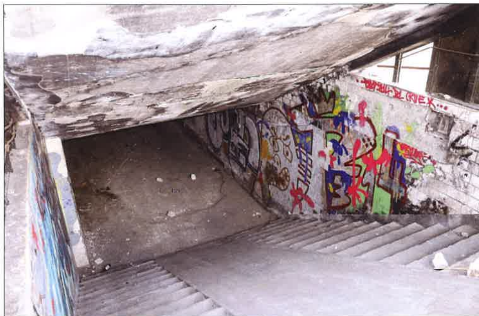
Wejście do przejścia podziemnego widoczne od strony północnej. (fot. Jakub Andrzejewski, 2020 r.)
