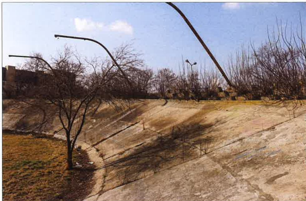
Widok ukształtowania betonowej części jezdnej która została wykonana etapami z widocznymi pionowymi i poziomymi dylatacjami. (fot. Jakub Andrzejewski, 2020 r.)
