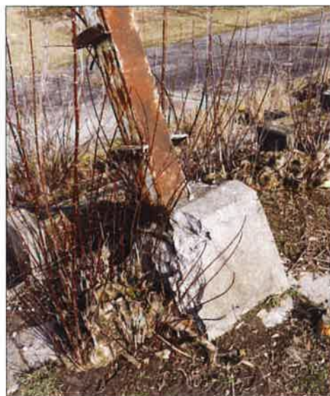
Żelbetowe fundamenty lamp do oświetlania toru. (fot. Jakub Andrzejewski, 2020 r.)
