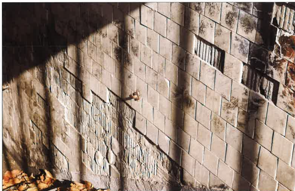
Ściany przejścia wyłożone płytkami ceramicznymi, widoczne także niewielkie mocowania poręczy schodowych - zdemontowane. (fot. Jakub Andrzejewski, 2020 r.)
