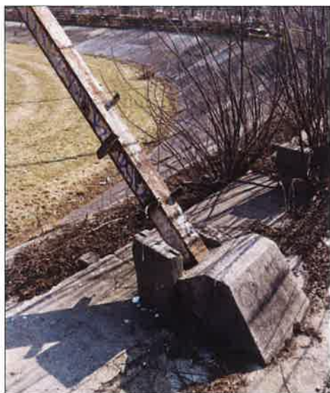
Żelbetowe fundamenty lamp do oświetlania toru. (fot. Jakub Andrzejewski, 2020 r.)
