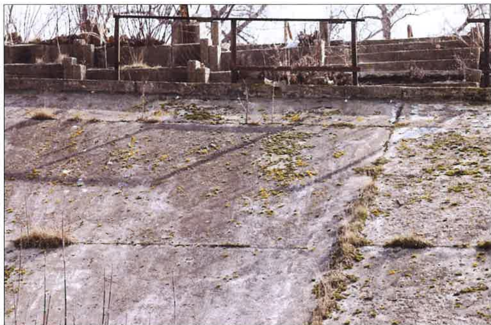
Betonowy toru jezdny z widocznymi dylatacjami, powyżej widoczne fragmenty zachowanych barierek oraz trybun. (fot. Jakub Andrzejewski, 2020 r.)
